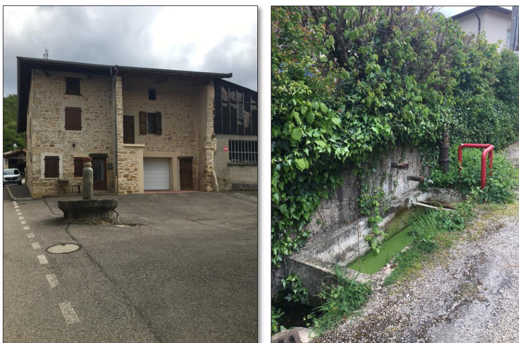
Photographie 17 - Fontaines sur le hameau de Reilleux, Mosaïque Environnement
