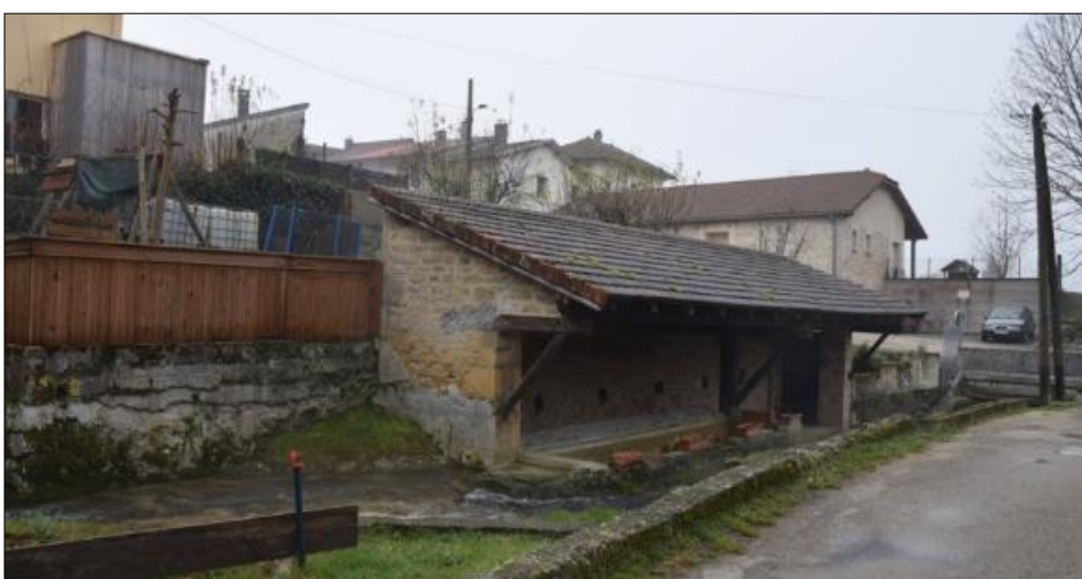
Photographie 15 - Lavoir dans l'ensemble bâti ancien, Mosaïque Environnement
