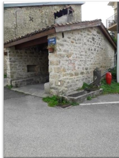
Figure 19 : Ancien four de la Charbonaz, Commune de Douvres
