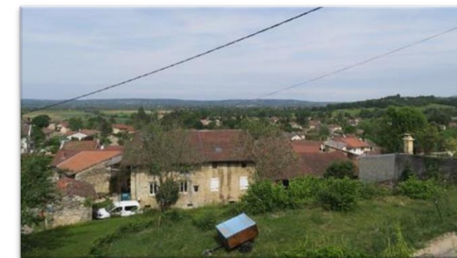
Figure 28 : Réseau électrique aérien, Mosaïque Environnement
