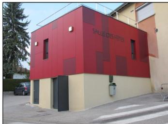
**Travaux de la salle des fêtes terminés :** ces derniers ont consisté principalement en des travaux d'accessibilité, de rénovation, de transformation, d'isolation thermique et phonique avec la création d'une nouvelle cuisine de plain-pied avec la salle principale.
